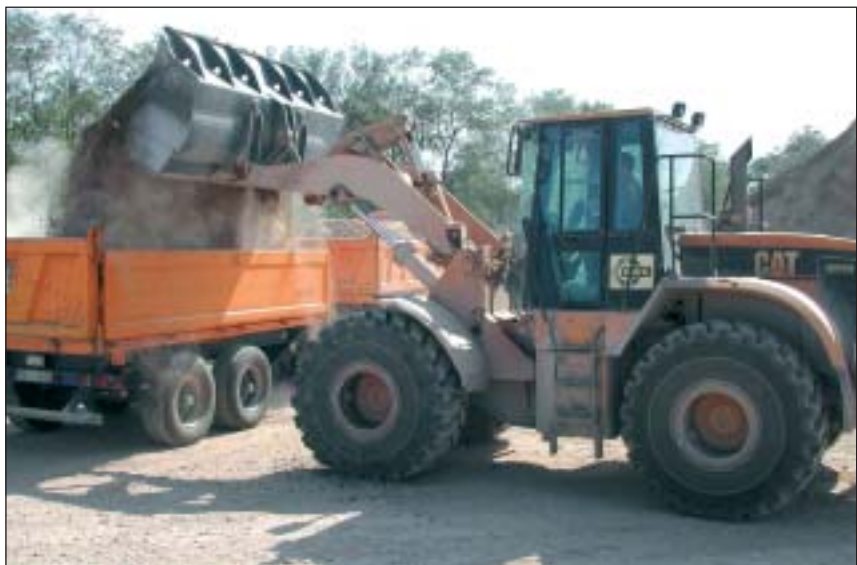
Auf den Anlagen der BWG arbeiten nur jeweils ein Radlader und zwei Mann Personal
